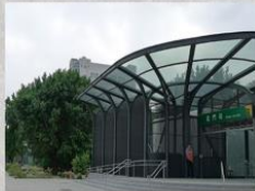
▲北捷松山線北門站
