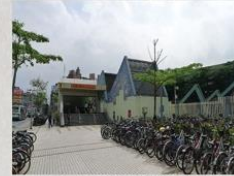
▲北捷蘆洲線徐匯中學站
