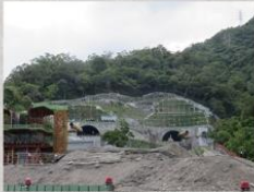
▲蘇花改A2標東澳隧道
