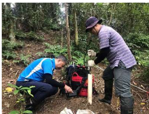
圖2、傾斜管量測情形
