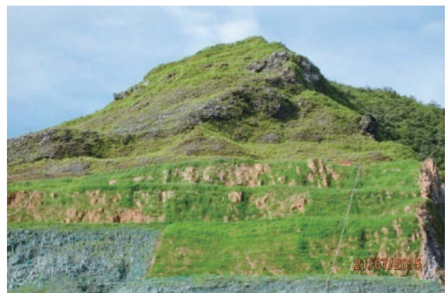
掛網噴植綠化工程
