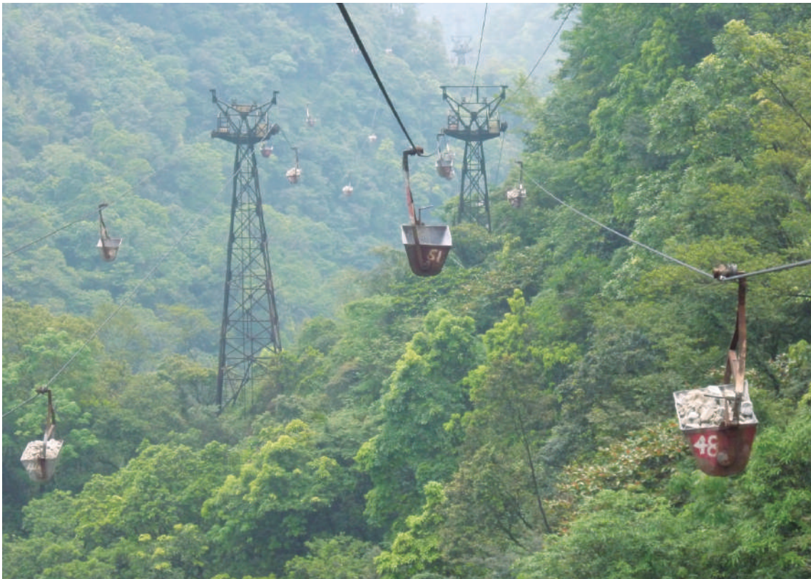
運搬工法：索道運搬系統
